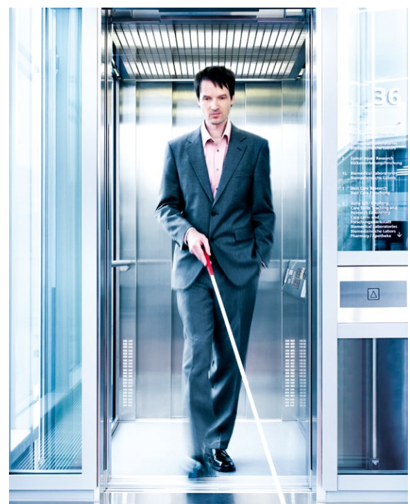
Der Lichtvorhang reagiert auch bei kleinsten Objekten
