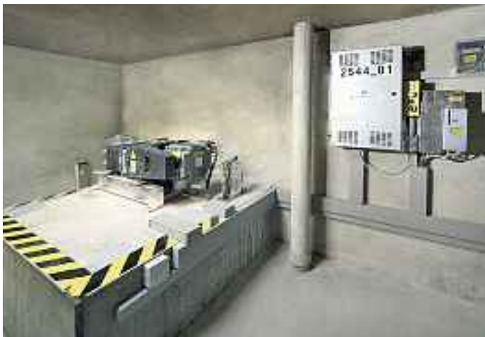
DR VAB verbunden mit einer Steuerung Typ CO BX und einem Antrieb Typ DR SGB 142.
